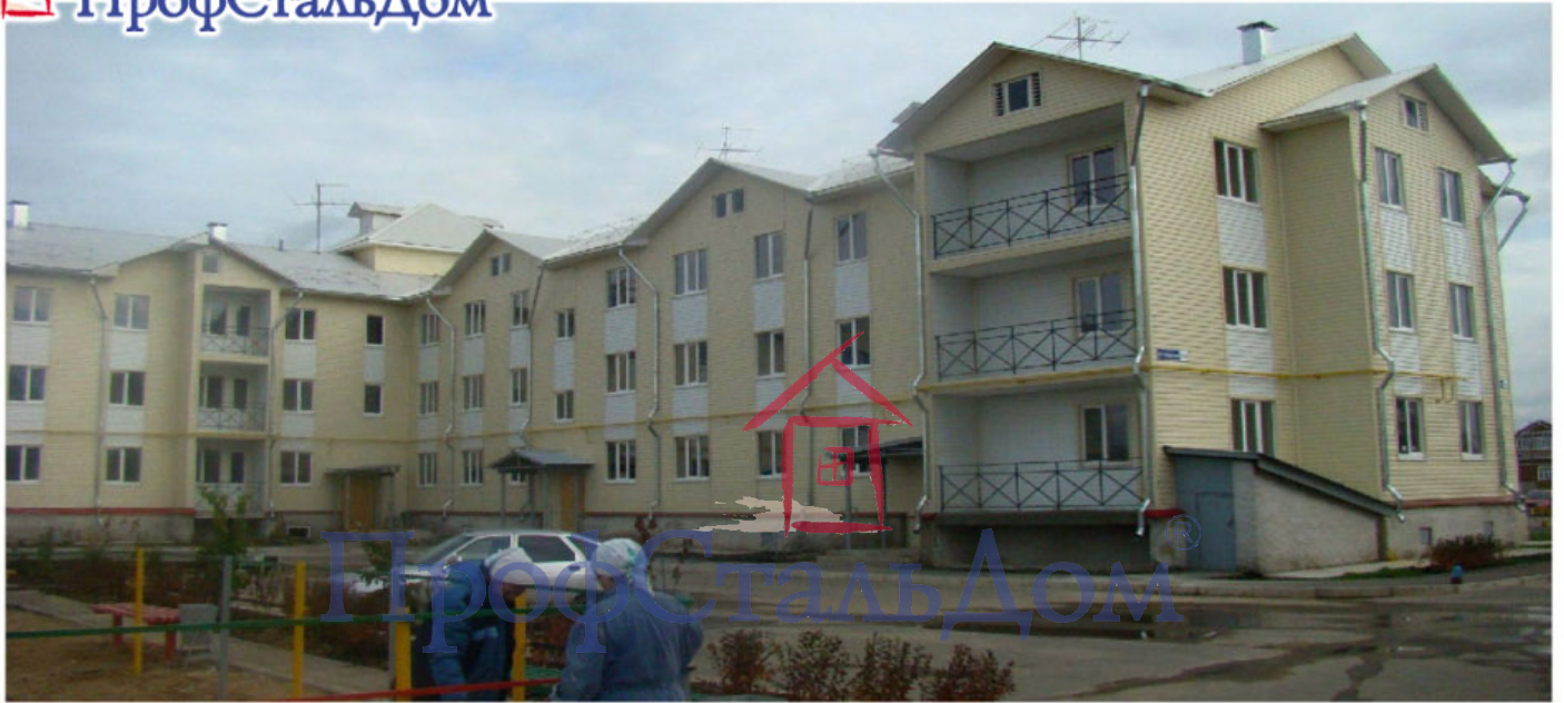
48-квартирный 3-этажный жилой дом
