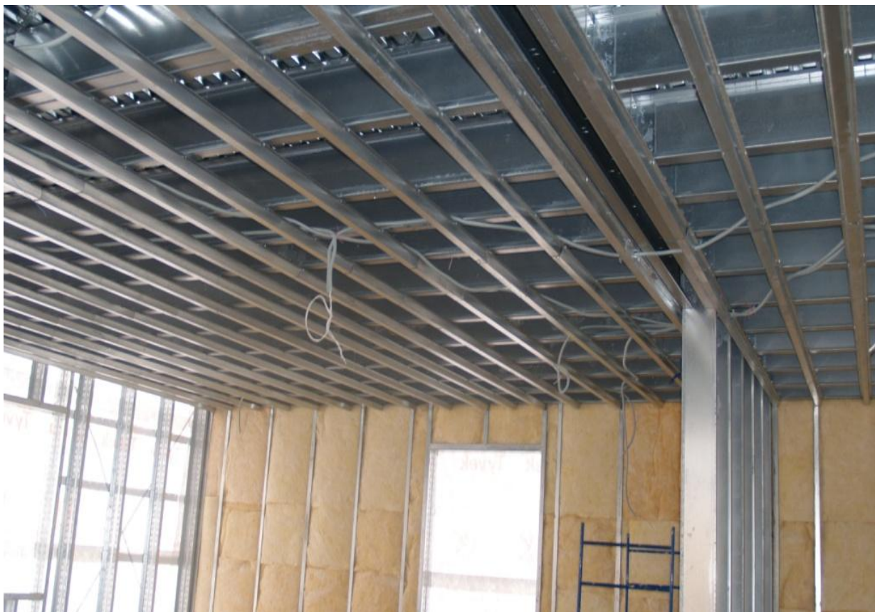
Рисунок 29- Обрешетка подвесного потолка из шляпного профиля ОП- 25
