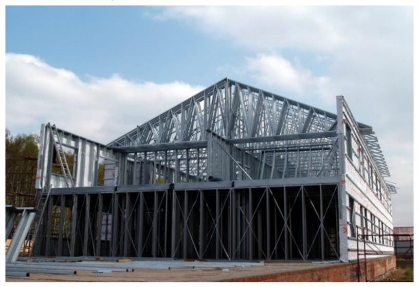
За последние 8–10 лет в нашей стране сформировалась новая отрасль строительной индустрии — производство легких стальных тонкостенных конструкций ЛСТК, что легло в основу для нашей компании разработать конструктивную систему строительства зданий **ПРОФСТАЛЬДОМ** ®.
