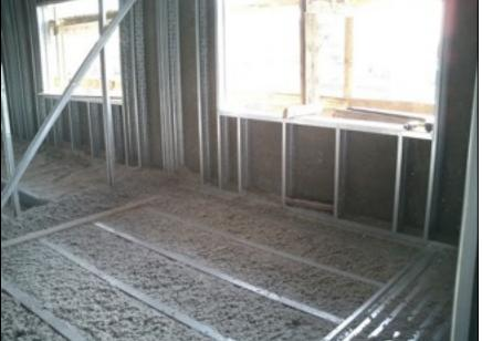
Например, для Центрального региона приведенное сопротивление теплопередачи стен и чердачных перекрытий составляет от 3.15 и до 4,7 м2\*°С/Вт соответственно (СНиП 23-02-2003 "Тепловая защита зданий"), что успешно реализуется в случае применения термопрофиля ЛСТК шириной 150-200 мм.
