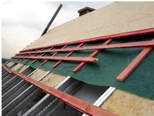
Устройство кровли.
