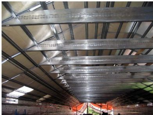
Укладка утеплителя.
